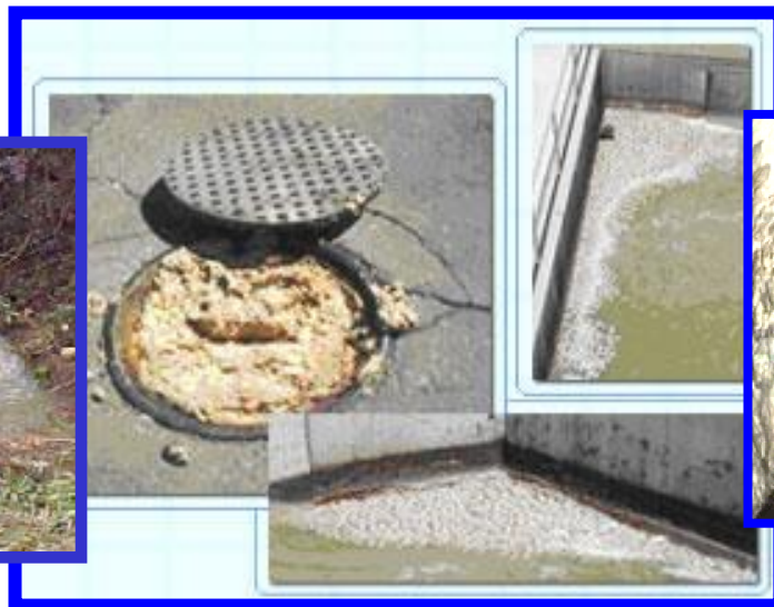
Slike: Efekti skupljanja Masti, Ulja i Masnoca u kanizacionom sistemu.
